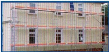
Fassadengerüst in Feldlängen bis 4,0 m
